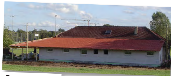
Das neue Dach
