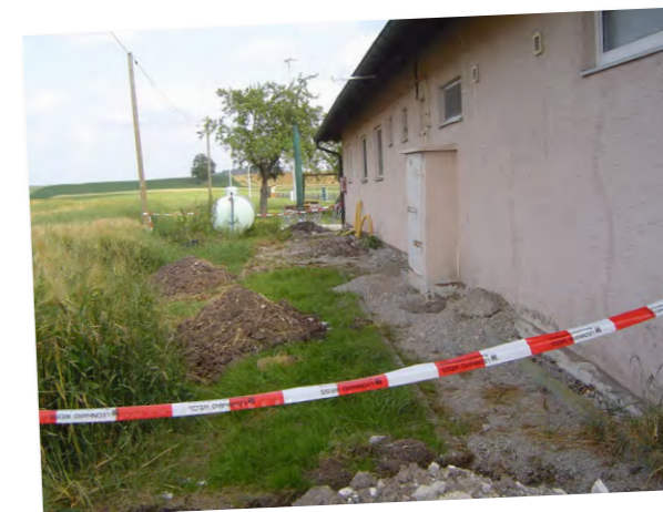
Rückansicht altes Vereinsheim nach der Baufeldräumung und vor Beginn der Bodenplatte.
